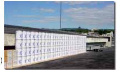
歩行用屋上スラブの全面リニューアル
