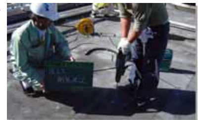
押さえ層に注入孔を穿孔
