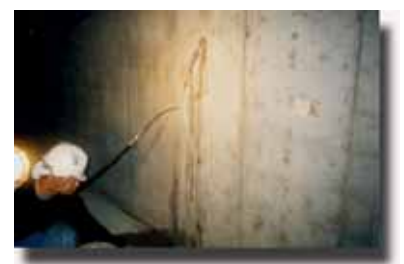
クラック注入状況
